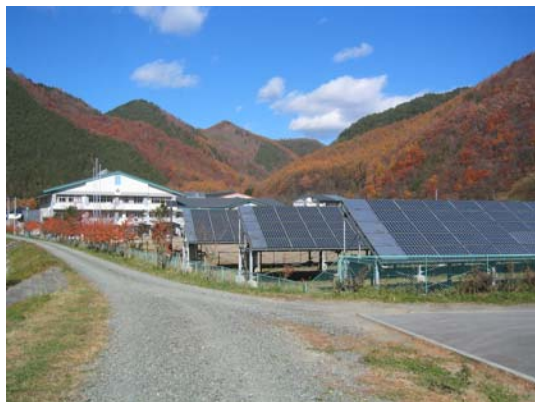
葛巻中学校太陽光発電所
