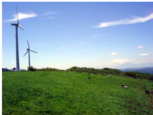
エコワールドぐずまき風力発電所
